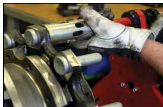
3 Montering af målingsudstyr
